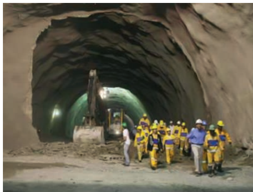
Túnel da Grota Funda
